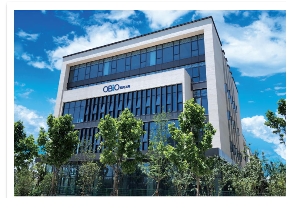
GMP生产大楼
